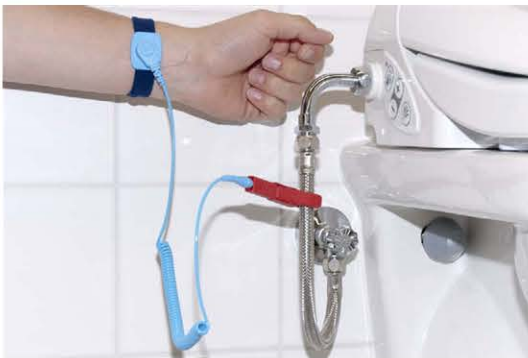
插图 2： 将防静电腕带与进水管上的一个金属部件相连
